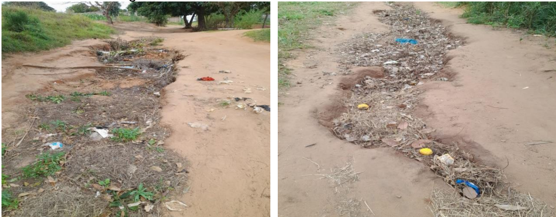
Figura 7 - Erosão laminar no bairro Josina Machel.
