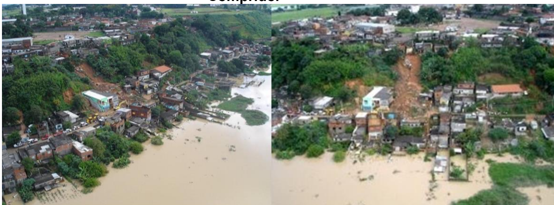
Figura 5. Deslizamentos ocorridos em área classificada como ZEIS, no bairro Rio Comprido.
