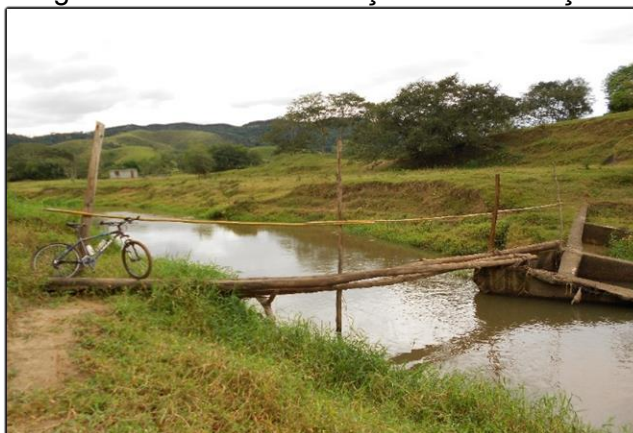
Figura 4 - Precárias condições de circulação.
