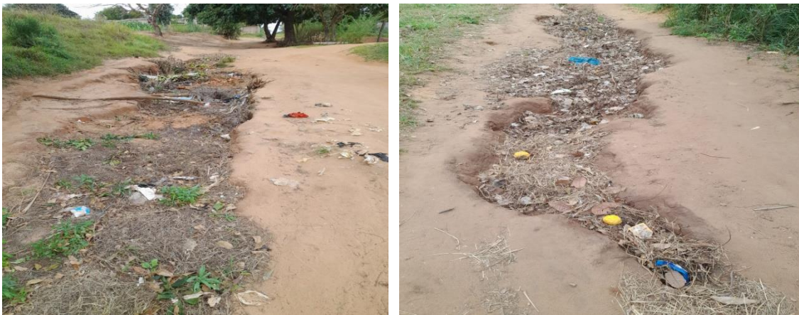
Figura 7 - Erosão laminar no bairro Josina Machel.
